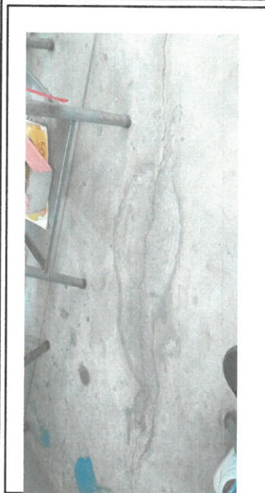
Foto 2: Implementación de piso cerámico (aula 1)
