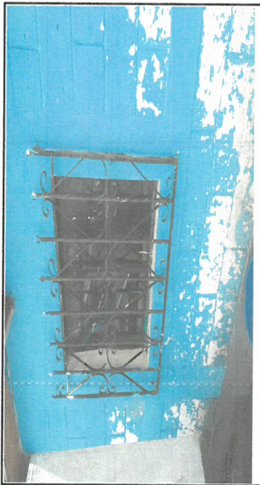
Foto 1: Ampliación de ventanas para mejoramiento de iluminación (cocina)
