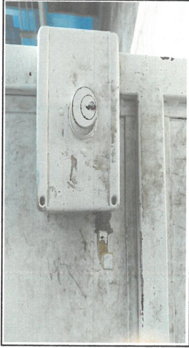
Foto 3: Sustitución de 2 chapas de puertas para aulas.
