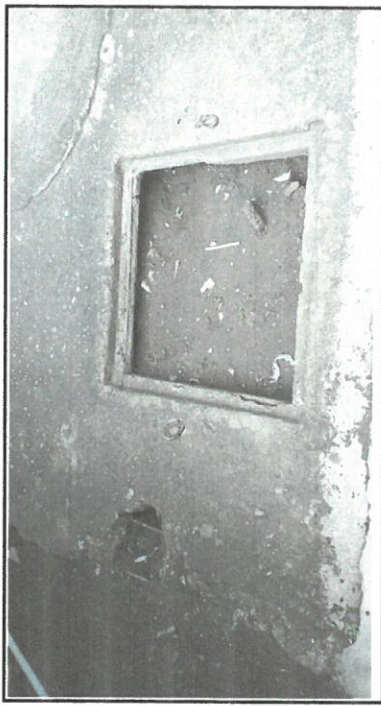
Foto 2: Mantenimiento de cajas de registro.
